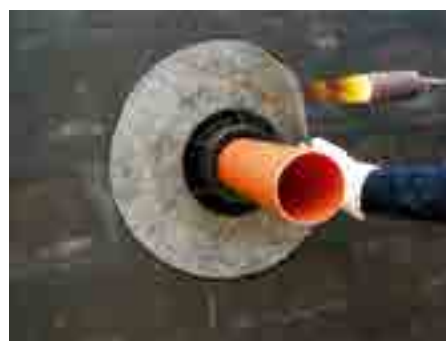
5. Zavariti bitumensku priрубnicu
