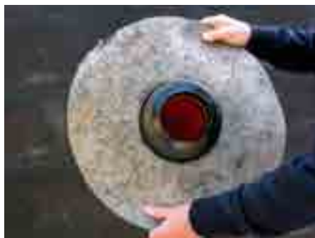
2. Postaviti bitumensku priрубnicu
